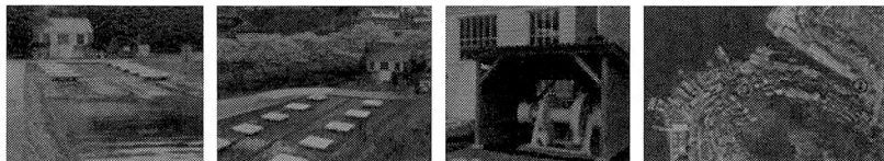
現存する日本最古のスリップドック「小菅修船場跡」1869年、薩摩藩とグラバーによって建設された船舶修理施設です。日本で初めて蒸気機関を動力とする曳揚げ装置が導入されました。船架の形状から「ソロバンドック」の名で親しまれています。また曳揚げ小屋は現存する日本最古の本格的な煉瓦造建築です。
