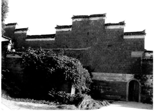
写真1 祠堂の西側側面
