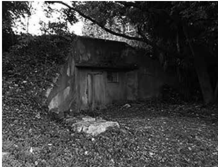
第6図 弾薬庫と呼ばれる倉庫跡
