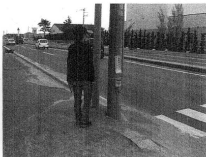
写真3 沈下した電柱と噴砂の堆積(日の出7丁目: 2011年4月11日撮影)
