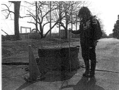
写真8 60cm 浮き上がったマンホール（東深芝：2011年4月10日撮影）
