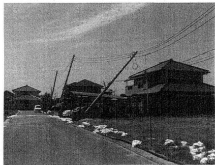
写真1 傾いた電柱(日の出5丁目:2011年5月8日撮影)
