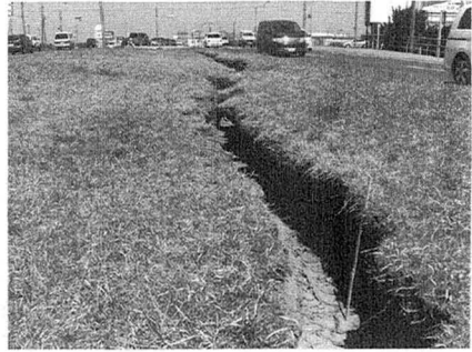
写真6 国道124号線中央分離帯に生じた亀裂 (掘割2丁目:2011年4月17日撮影)
