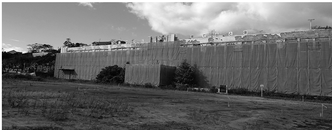
写真6 シートで覆われた旧門脇小学校被災校舎 [井関撮影 (2018/11)]
