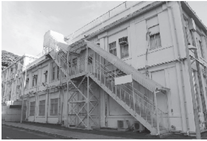
第12図 GPSOが一時期活動していた建物 旧横須賀海軍工廠製図・刷版所だった。 (2015年当館撮影)
