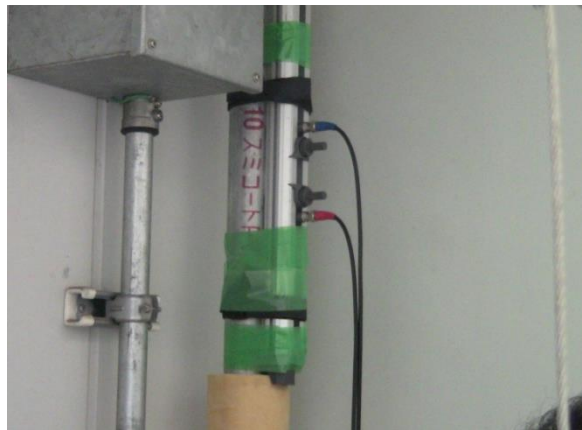
写真 3. 1. 1-6 流量計検出器の設置（全階）
