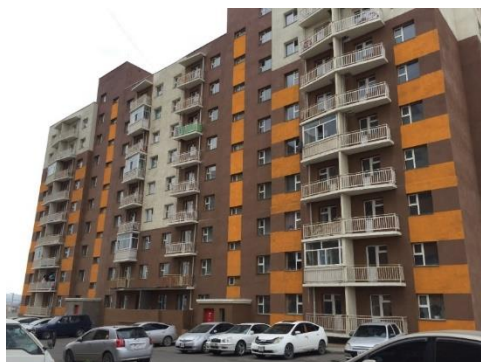
a 再開発事業によって建てられたアパート
