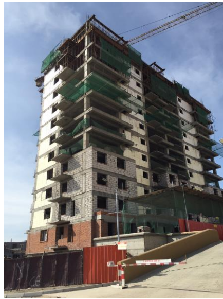
b 建設途中のアパート
