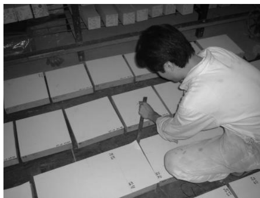
写真 2-3-1 タイルカーペットの剥がし状況
