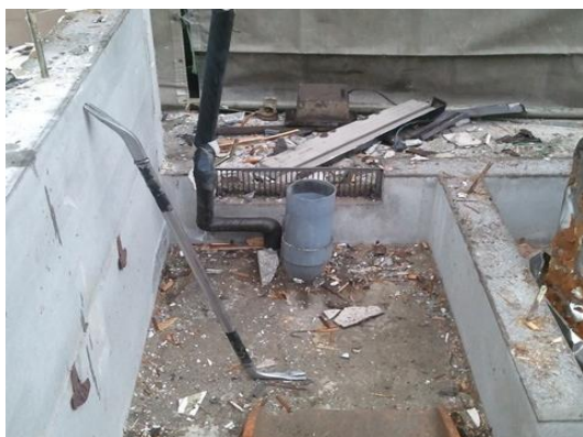
写真 2-2-1 解体現場における調査の例 (左：上屋塩ビ管，右：埋設塩ビ管)
