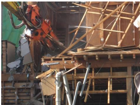
写真 2-4-1 塩ビ管撤去作業風景
