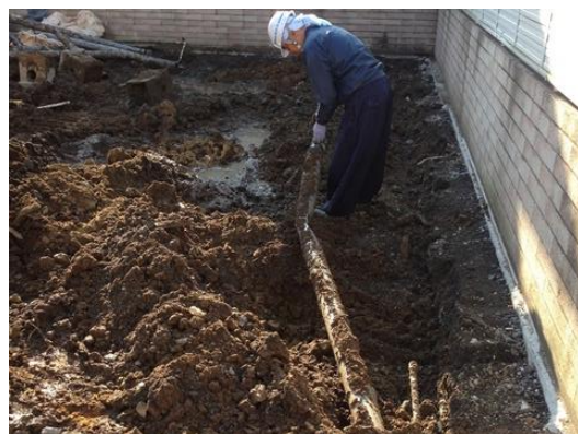
写真 2-2-1 解体現場における調査の例 (左：上屋塩ビ管，右：埋設塩ビ管)
