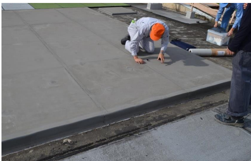
写真4-4-1 実暴露された防水シートの採取状況
