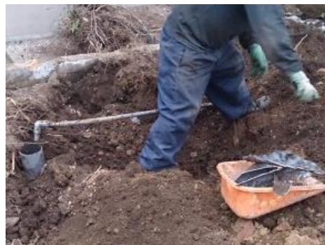
写真 2-4-1 塩ビ管撤去作業風景
