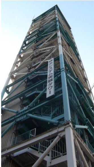
写真 3.2-1 実大排水タワー
