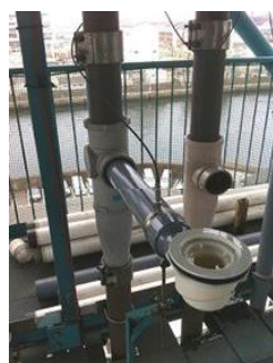
写真 3.2-3 排水横枝管末端の様子
