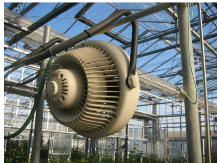
写真 1-2 試験温室に用いた循環扇
