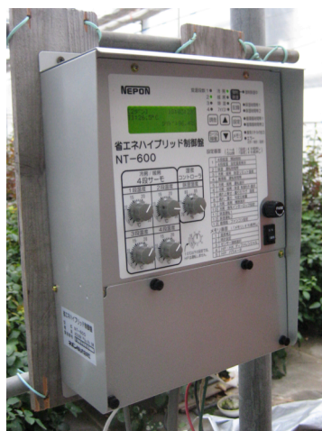
写真 1-3 試験に用いたハイブリッド制御盤 NT-600
