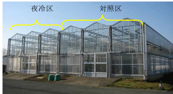
写真 2-1 試験に用いたフェンロー型温室
