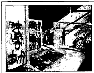
写真 3-2-2 住棟壁面への落書き
